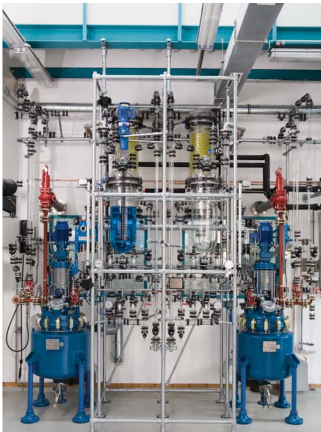
Abb. 1: Zwillinganlage mit Verschaltung
